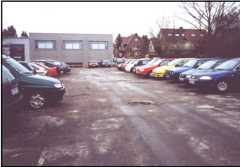
Abbildung 4.1: Ursprungszustand des Pkw-Parkplatzes
