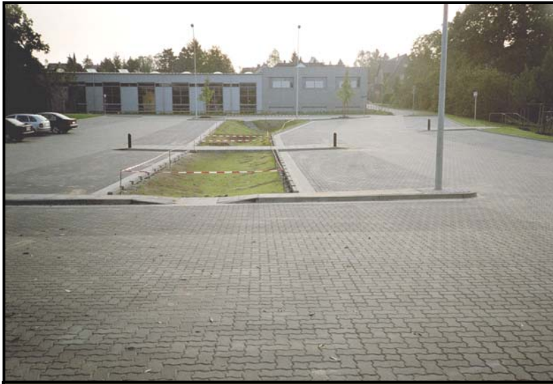
Abbildung 4.2: Ansicht der Versickerungsmulde der FH Wolfenbüttel/Braunschweig
