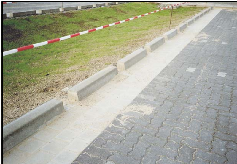
Abbildung 4.3: unterbrochene Bordlinie als Zulaufmöglichkeit für das Regenwasser
